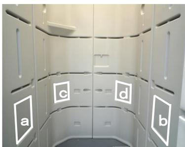
① トイレ室内2か所(洋式用・和式用 各1か所)へペーパーホルダー金具を取付けし、棚付ペーパーホルダーが着脱できるようになります。
