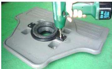
① 写真Aのように、トラスタッピン(M4×25)で着脱パネルに床フランジを取り付けます。
